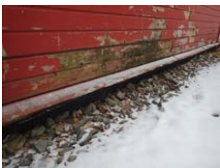
Skadet bordkledning
