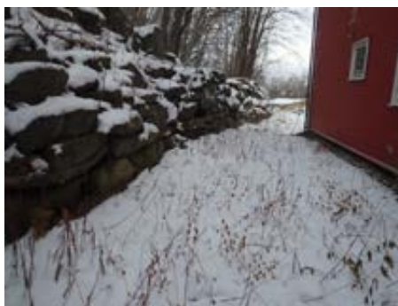
Forstøtningsmur i naturstein - øvre side.
