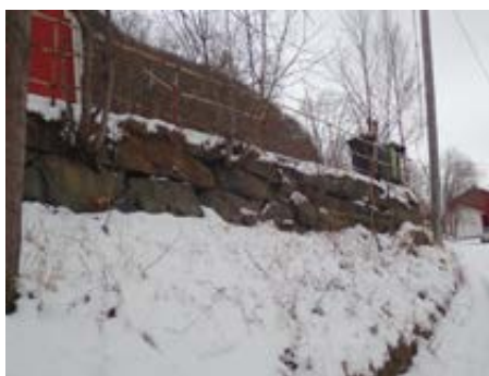
Forstøtningsmur i naturstein m/rekkverk.
