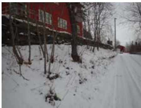
Forstøtningsmur i naturstein
