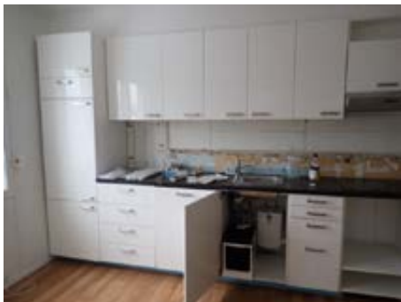
Innredning med vvb i benkskap under oppvaskkum.
