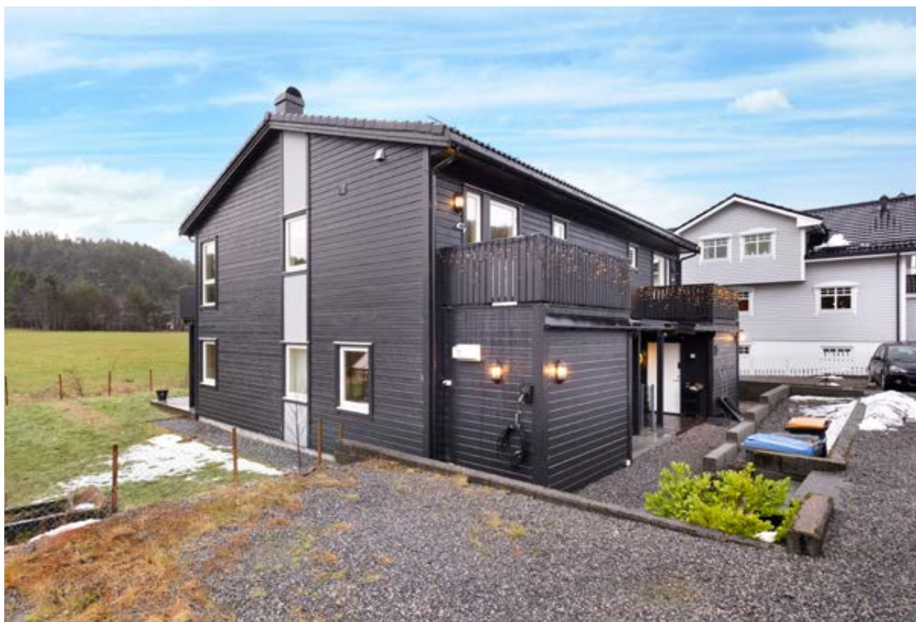
Saltakskonstruksjon med betongtakstein gir et solid takdekke
