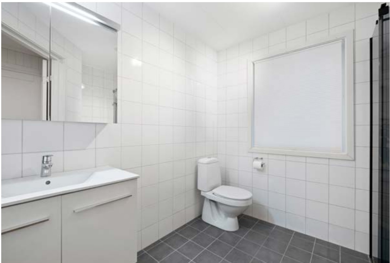
Flislagte vegger og gulv med varmekabler på badet
