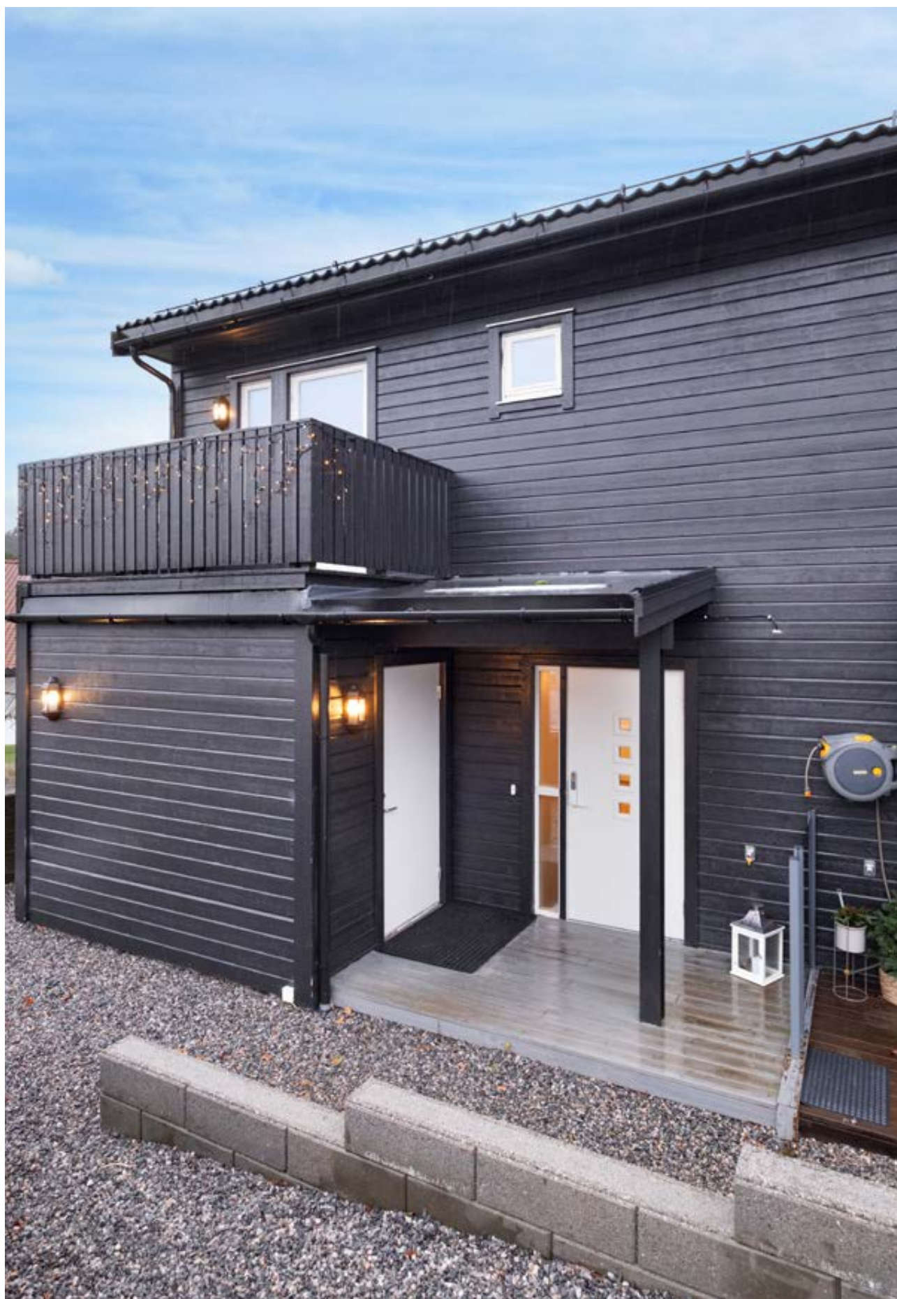
Inngangspartiet har overbygg teknet med PVC-duk
