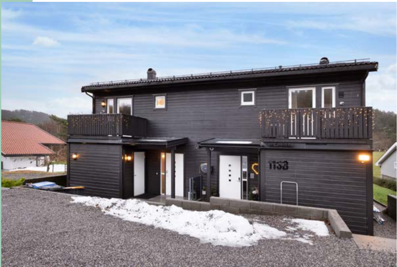
Boligen har en moderne fasade med liggende bordkledning og 3-lags vinduer
