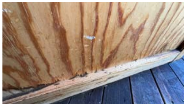
Hull etter borebiller.
