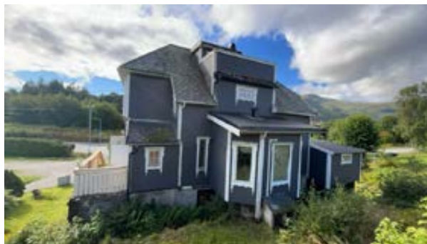
Bildet av taket fra baksiden av boligen.
