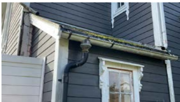
Eldre overgang fra takrenne til nedløp.
