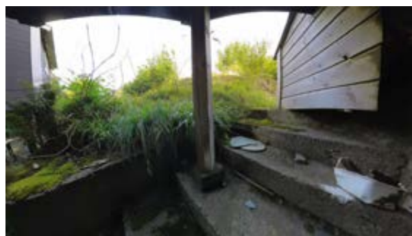
Tilbygg er plassert på søyle som står på betongkloss
