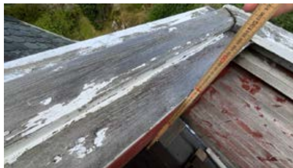
Eksempel på værslitt rekkverk.
