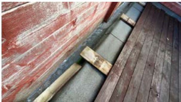
Takterrassen ligger over badet i 2. etasje.
