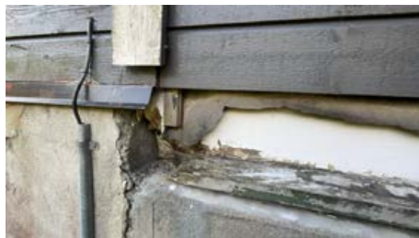
Råteskader.
