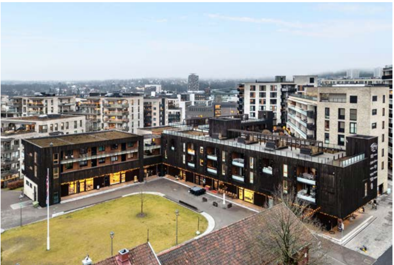
Sandakerveien 104 er et kombinert bolig- og næringsbygg hvor første etasje består av dagligvarebutikk, apotek og blomsterbutikk.
