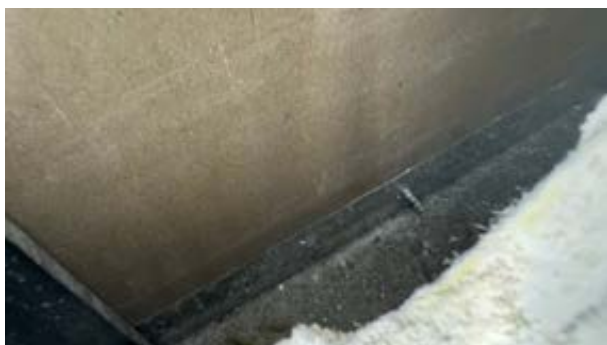
Bilde viser i hulrommet uten synlige tegn til fukt. Vegg består av bindingsverk med stålstendere.
