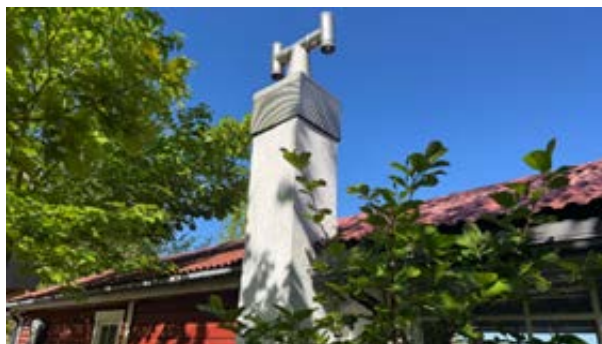
Pipe av mur av ukjent alder med påmontert topphatt.
