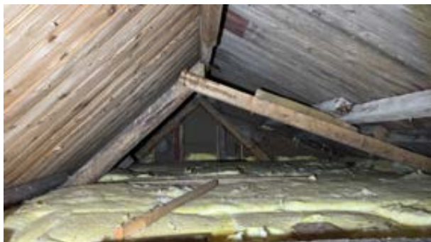
Takkonstruksjoner med sperret ås.
