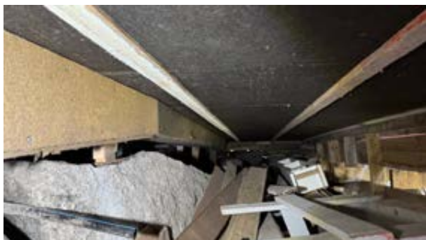
Underkledd med asfalt vindtett.
