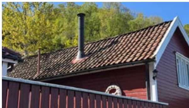
Pipe av stål av ukjent alder.
