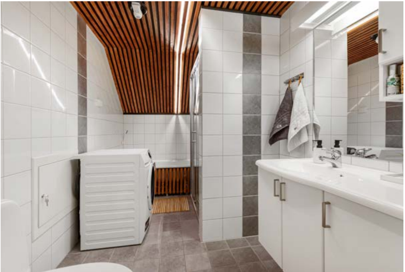
Elektriske varmekabler og mekanisk avtrekk sikrer komfort og god ventilasjon.
