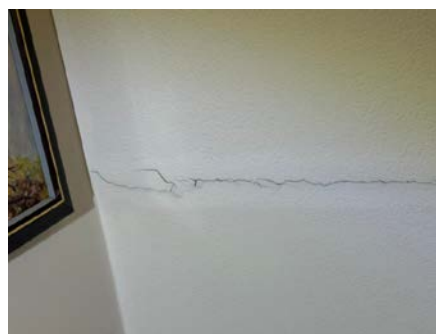
Setninger i etasjeskiller i gang
