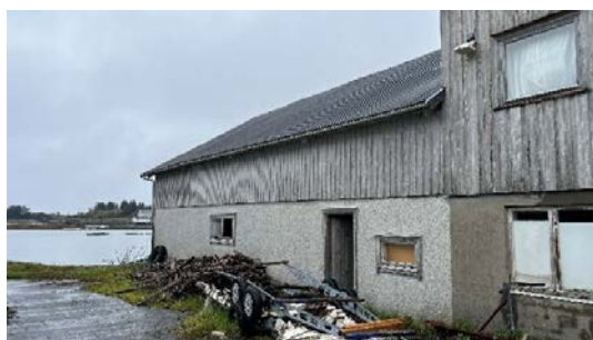
Råteskadet kledning
