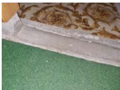
Betongsokkel ved alle vegger.
