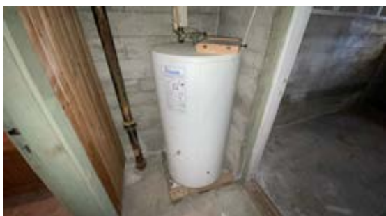
Varmtvannsbereder.
