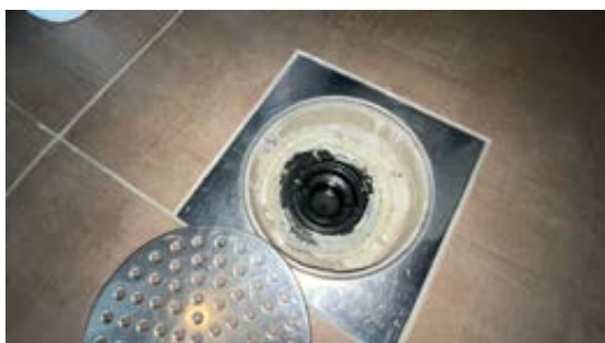
Plastsluk på vaskerom.
