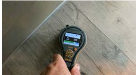
Ingen unaturlige verdier ved fuktsøk foran oppvaskmaskin.
