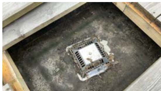
Sluk(nedsenka renne), i følge rekvirent er det overløp sør.
