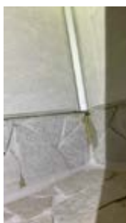
Fugeslipp mellom bunnprofil og veggplate idusjnisje
