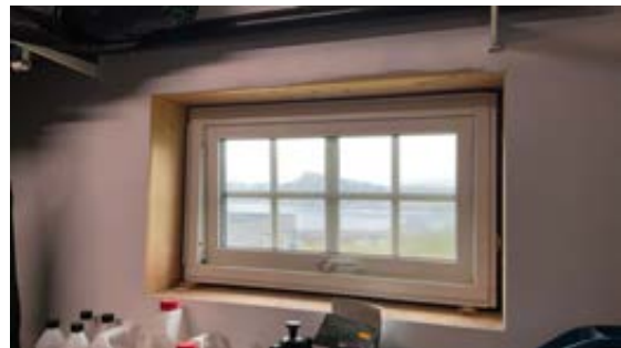
Gjenstår sluttmontering vindu
