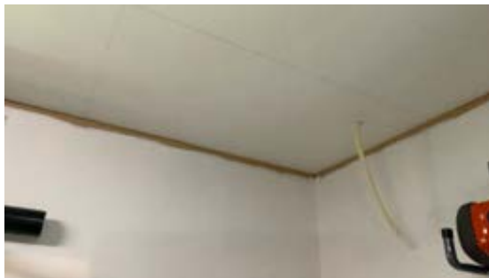
Gjenstår sluttmontering listverk
