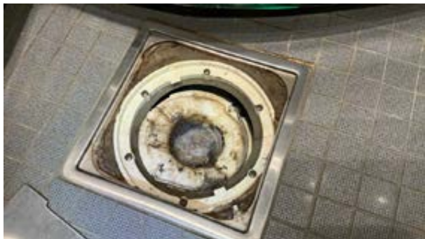
Sluk på bad
