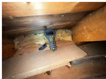
Sperrerom er fullisolert stedvis. Ikke målt forhøyet fuktverdier på befaringen.
