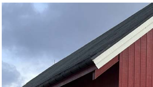
Takkonstruksjon av stål tekket med asfaltapp.
