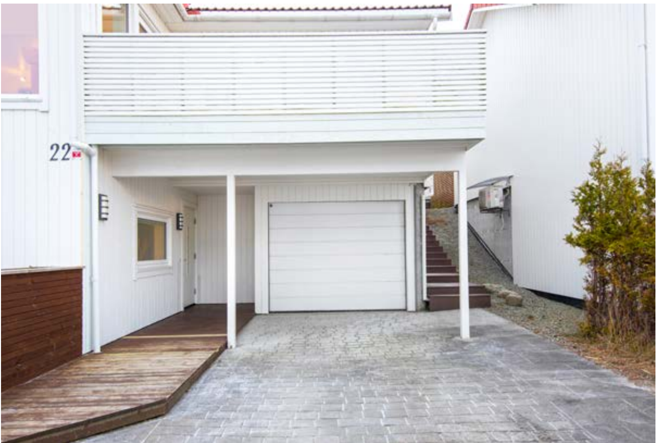
Gårdsrom og garasje
