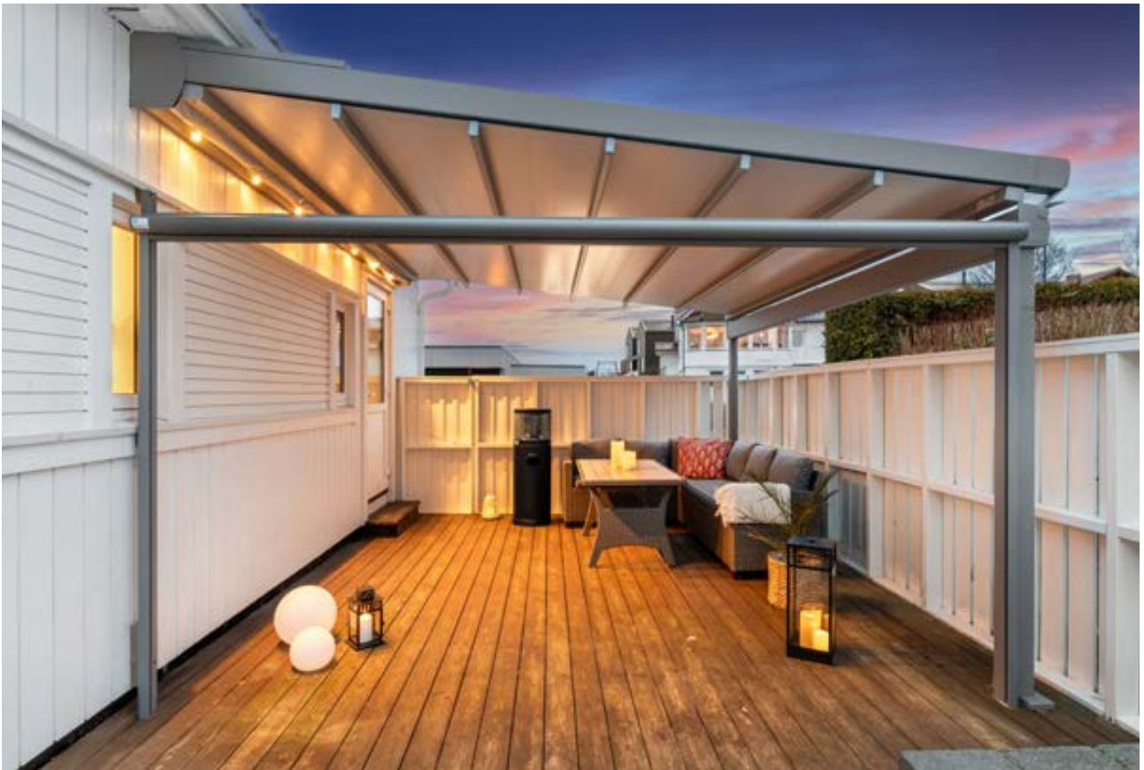
1. etasje: Ut i fra det ene soverommet har man adkomst til en herlig inngjerdet terrasse med stedbygd pergola. Elektrisk markise som skygger for solen eller beskytter mot regnet.
