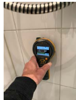
Ingen unormale utslag med fuktindikator på dusjvegger
