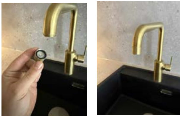
Figur 6 Skifte av filter i blandebatteri - eksempel
