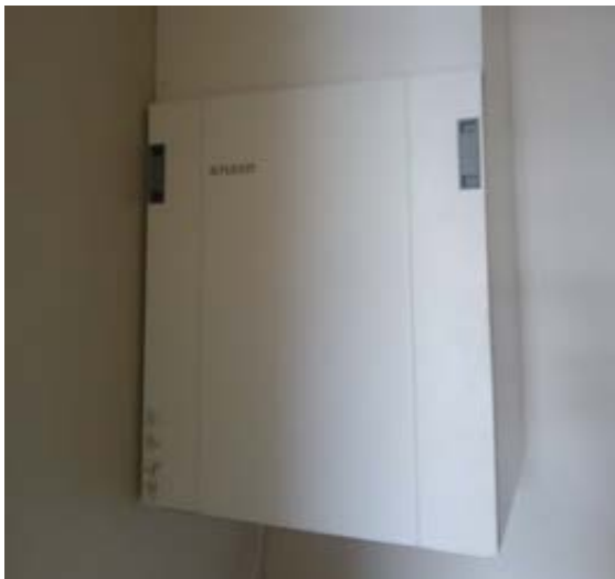
Figur 11 Eksempel på aggregat i bod i leilighet
