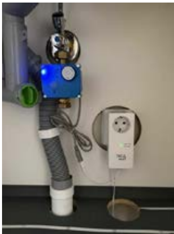
Figur 7 Automatisk lekkasjestopper
