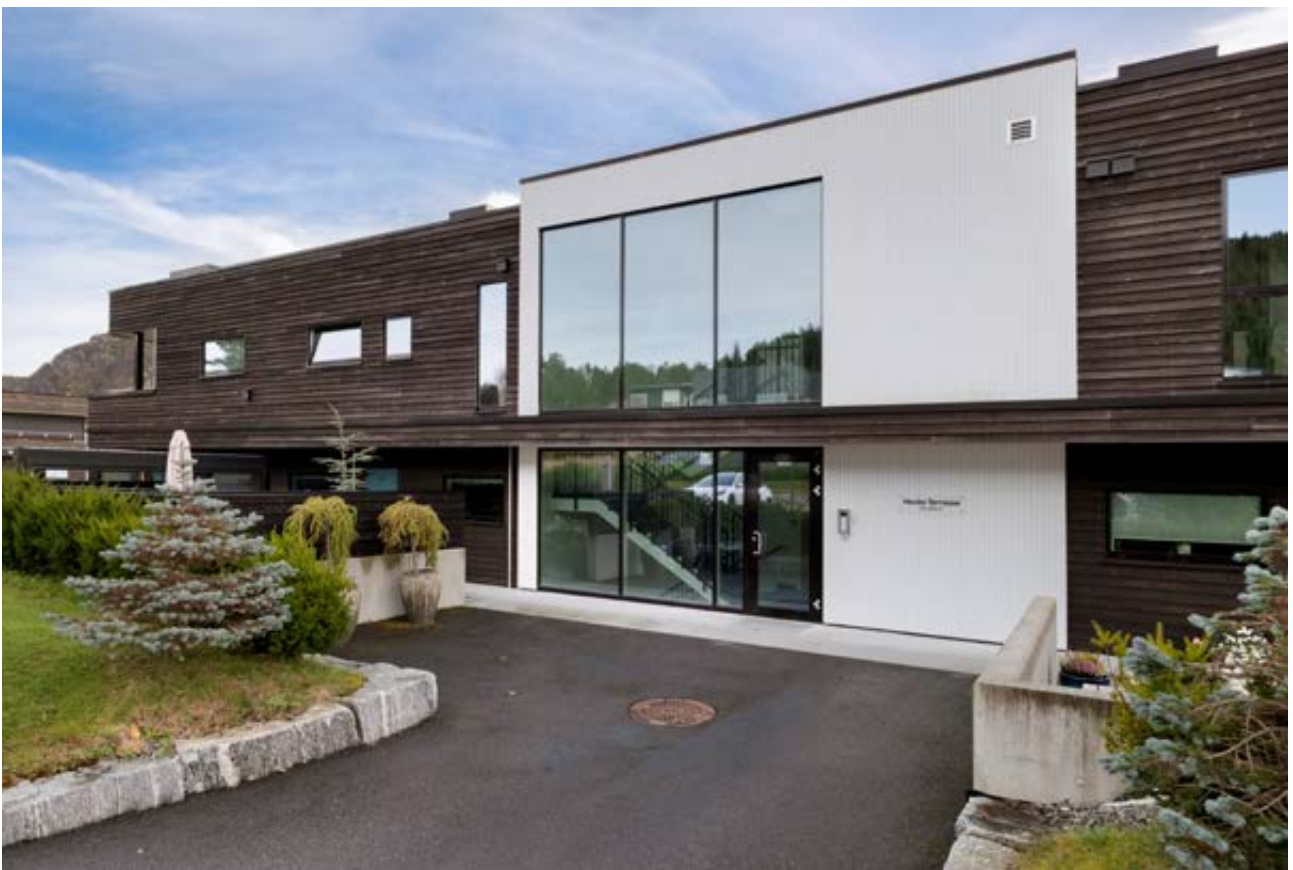
Leiligheten har en moderne fasade med store vindusflater og hovedinngang i aluminium, som gir et stilfullt preg
