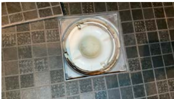
Sluk bad øst
