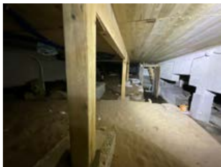
Avstiving/ ekstra støtte montert under bjelkelag.
