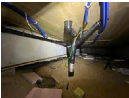
Avløpsrør i krypekjeller.
