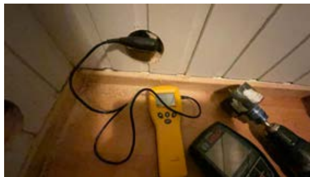
Hull for fuktkontroll boret fra gang.
