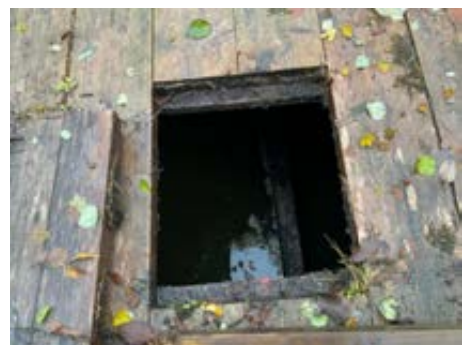
Inspeksjonsluke i lokk.
