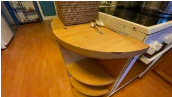
Synlig skade på benkeplate.
