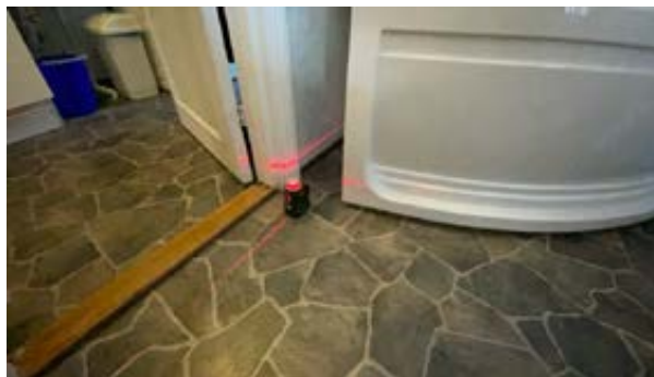
Kontroll av fall med lasermåling. Ingen oppkant/sikring på belegget i dør.
