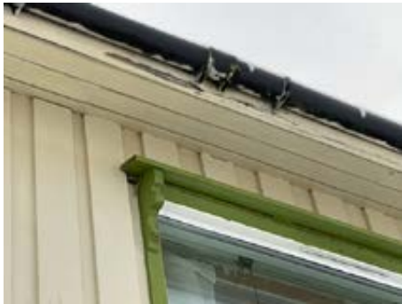
Synlig råteskade
