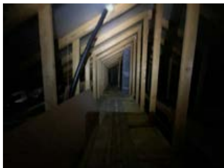
Sperrekonstruksjon med bærende stolper.
