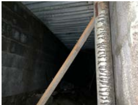
Bilde inn i utvendig kanal/ kryperom langs byggets bakside.
