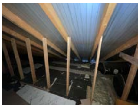
Synlig lufting ved takfot.
