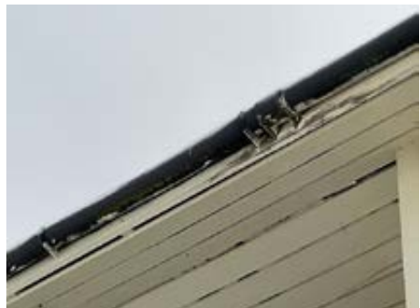
Synlig råteskade
