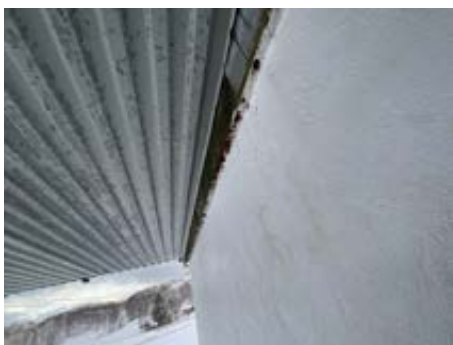
Lufting bak kledning fylt med skum.
