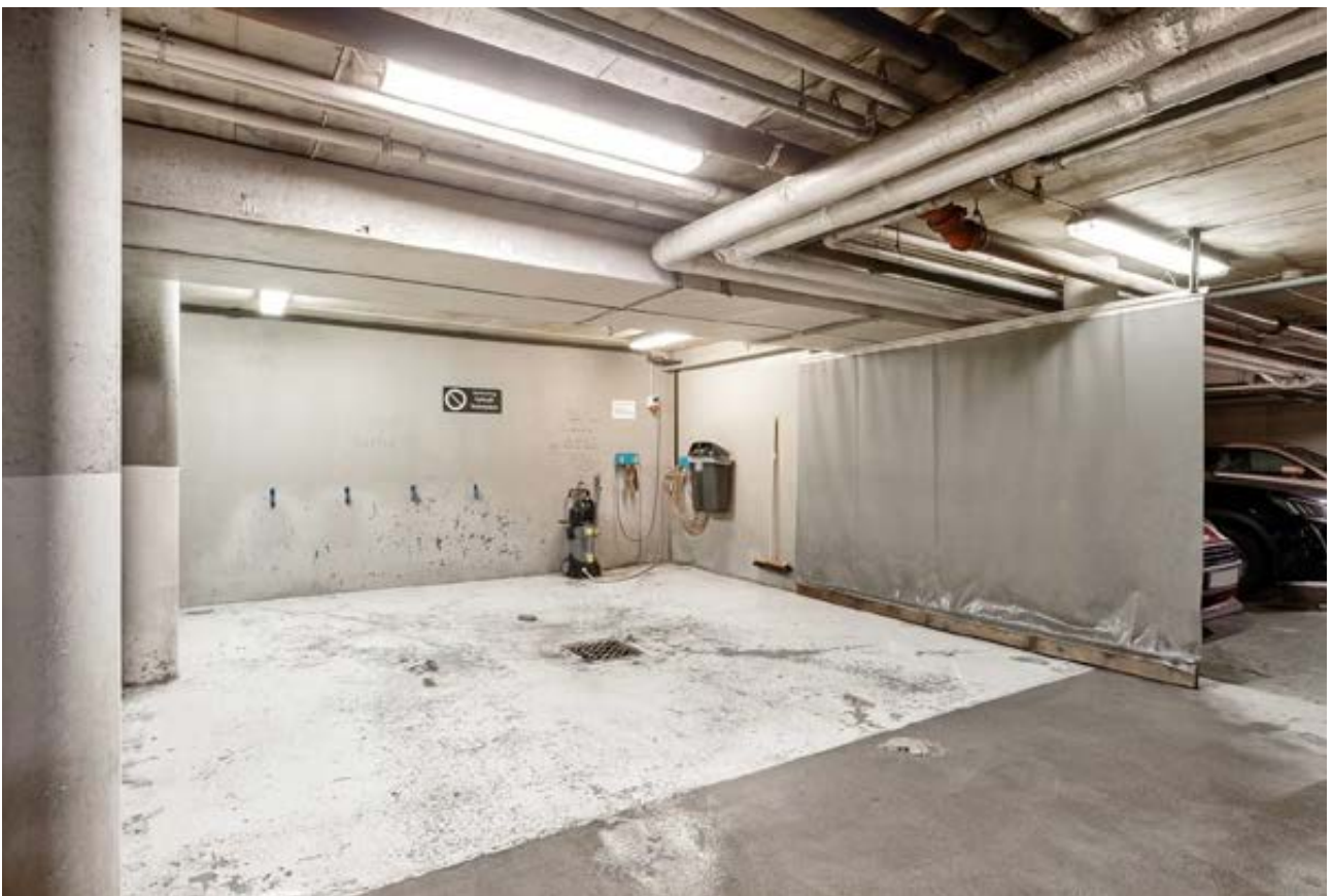
Parkering i anlegg. Her er det også satt opp vaskeområde for biler
