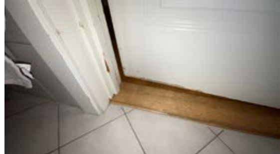
Skader på dørkarm og dørblad bad
