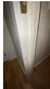
Skader på dørkarm og dørblad bad
