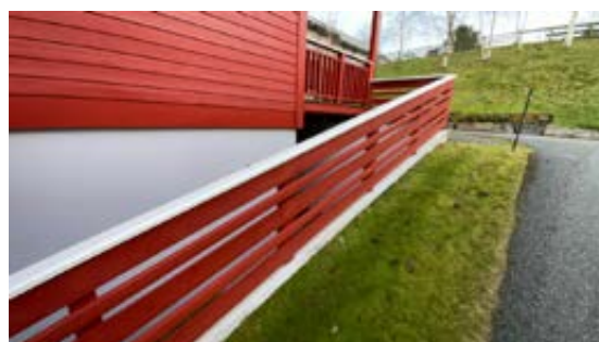
Rekkverk på støttemur
