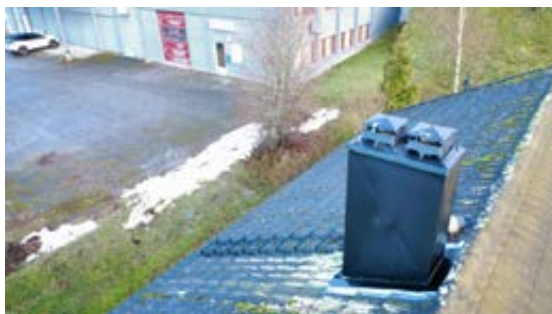
Pipehatt og fastmontert takstige
