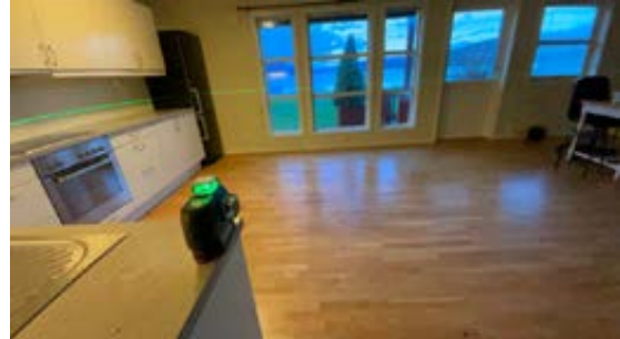
1. etasje Plassering av laser ved kontroll av stue/kjøkken. Det er målt 17 mm høydeforskjell gjennom rommet. TG 2
