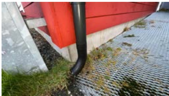
Takvann er ført til terreng ved inngang
