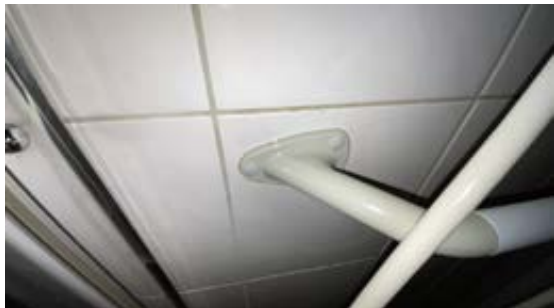
Riss/sprekk i flis ved håndtak i dusj
