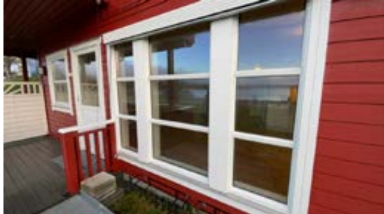
Oversikt vinduer på stue
