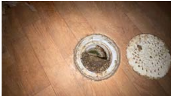
Sluk bør rengjøres og kontrolleres jevnlig
