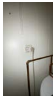
Ekstra uttak på stikkontakt bør fjernes.
