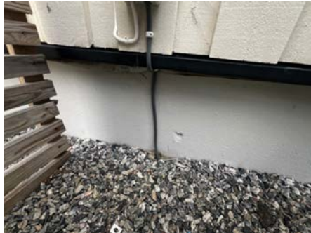
Strømkabel til jacuzzi som mangler beskyttelse.
