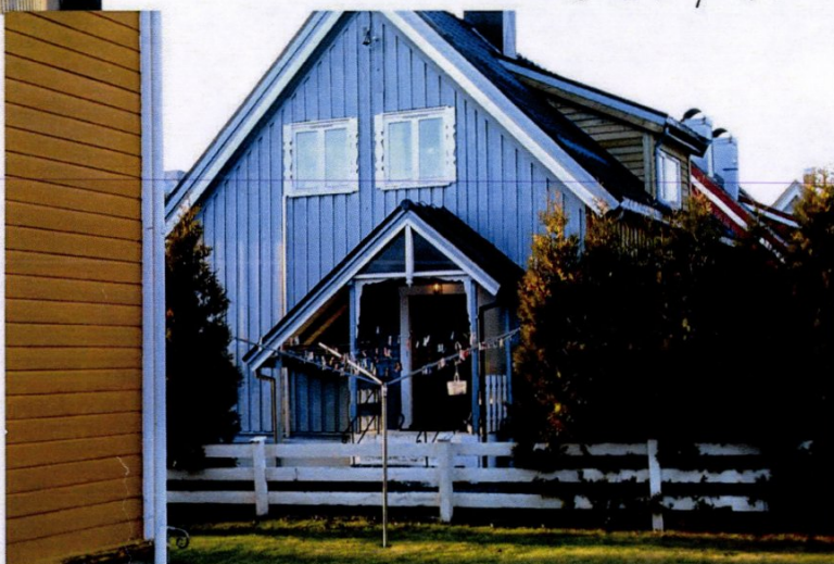
Eksteriør Fasade sett fra Øst.
