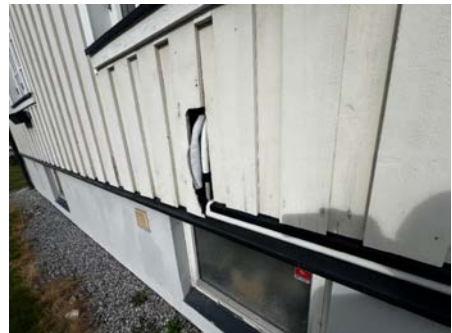
Stor åpning i vegg for rørgjennomføringen til varmepumpe.
