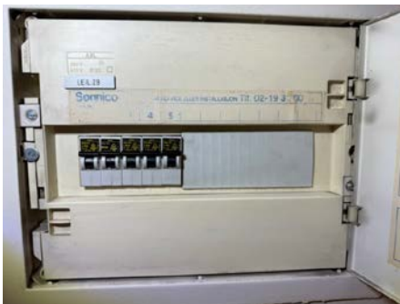
Elskap, plassert i entre. (eldre sikringer med begrenset kapasitet)
