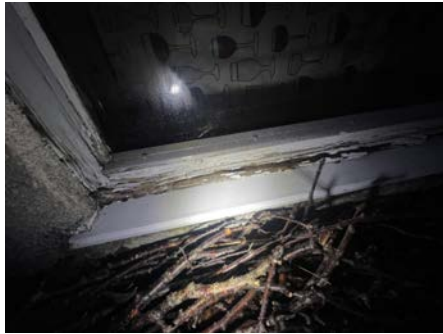
Råteskadet kjellervindu.
