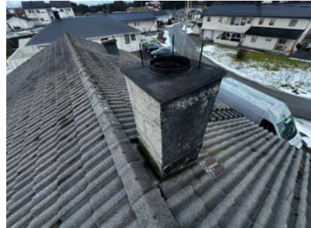
Oversiktsbilde av skorstein over tak.
