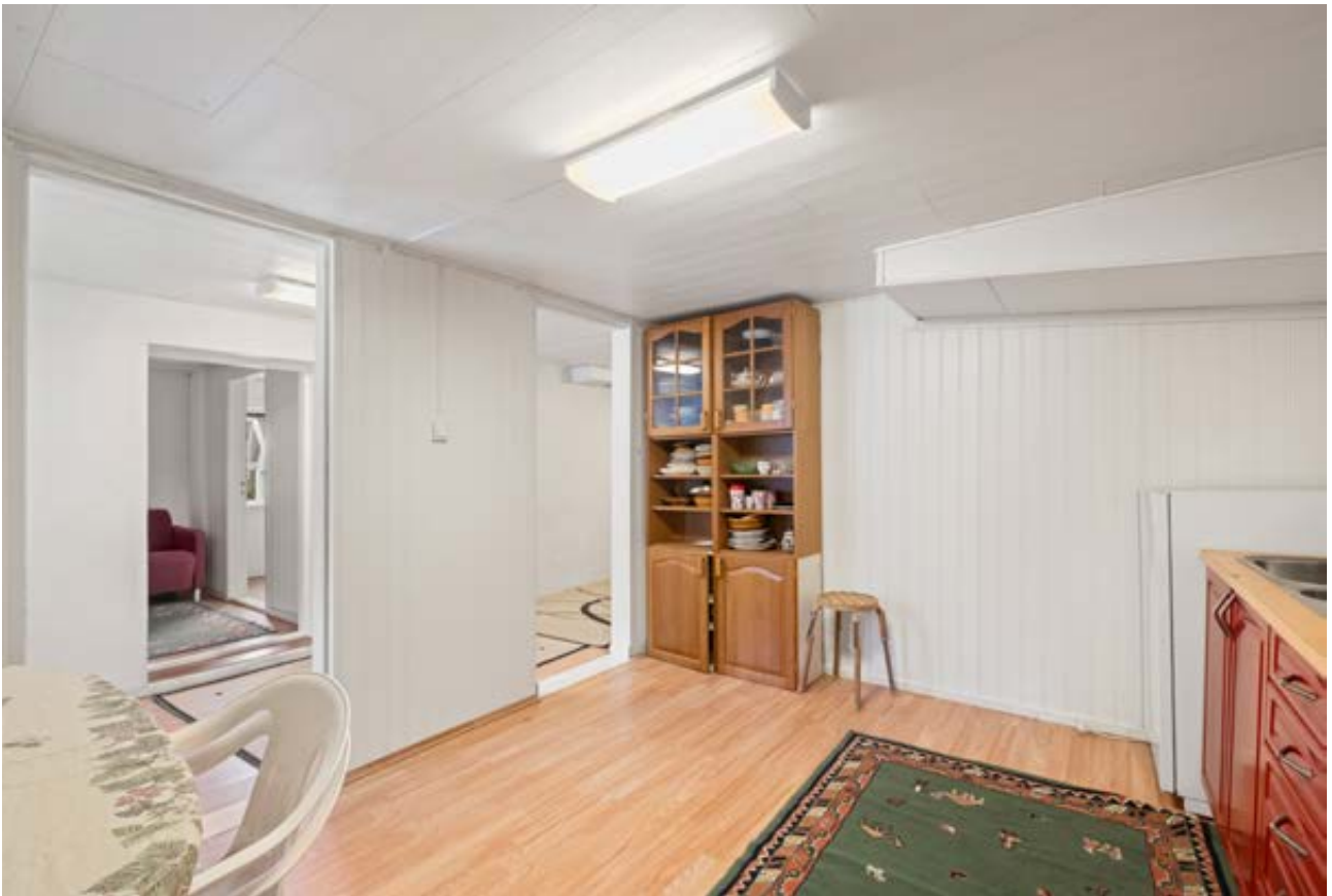
Rommet er ikke godkjent for varig opphold/beboelse (det er ikke søkt om bruksendring)
