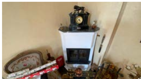
Innmurt vedovn i 1. Etasje.
