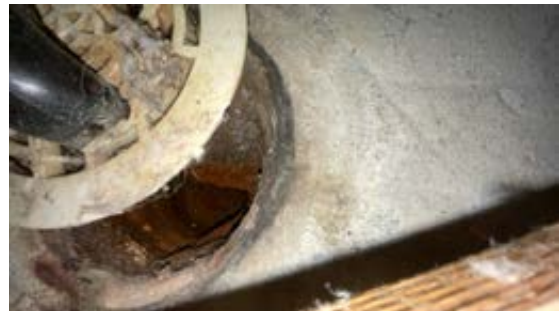
Sluk uten tettesjikt ved/under klemring.
