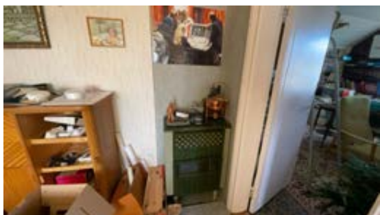
Eldre kamin, må påregnes byttet
