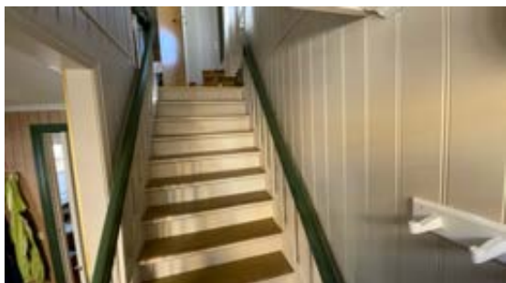
Innvendig trapp mellom 1. Etasje og 2. Etasje.
