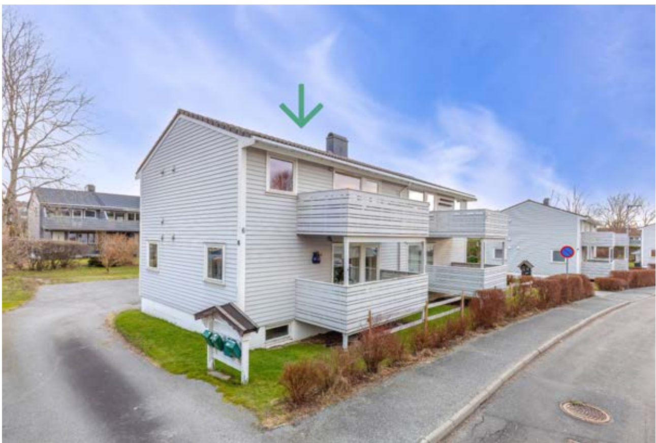
Fasade med pil på leilighetens beliggenhet
