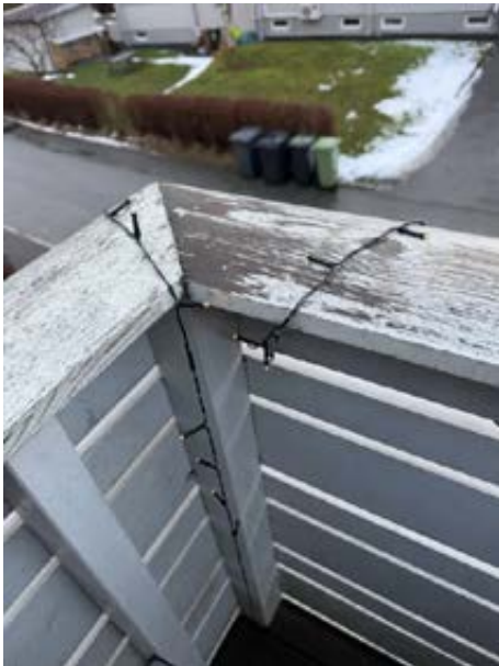
Hånd-rekke fremstår som slitt.
