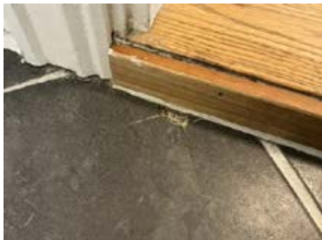
Skade på flis ved terskel. Opp-kant/membran er synlig bak terskel-list.
