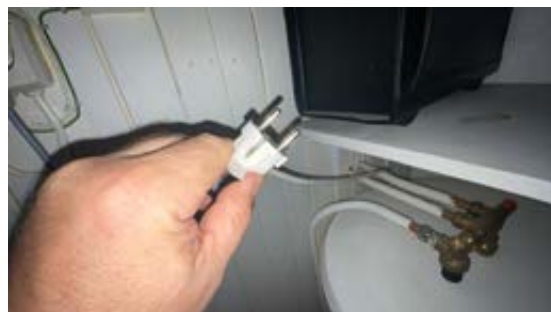
Ingen svimerker på stikk ved dagens befaring.
