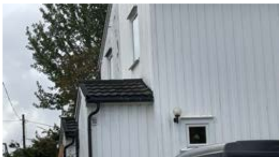
Tak over inngangsparti
