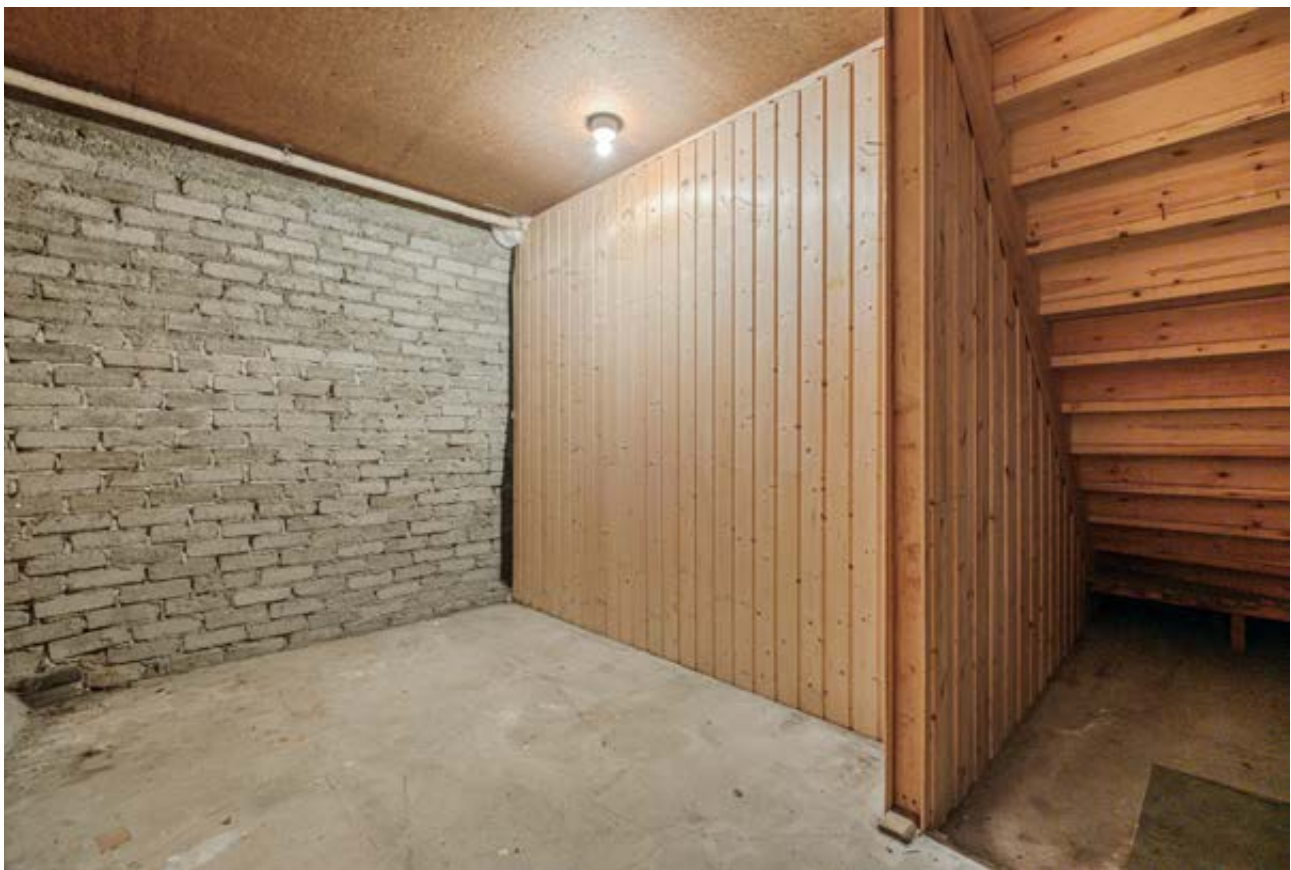
Bod 1 (vest). Med unntak av trappen så er denne delen av underetasjen byggemeldt/godkjent som ikke utgravid
