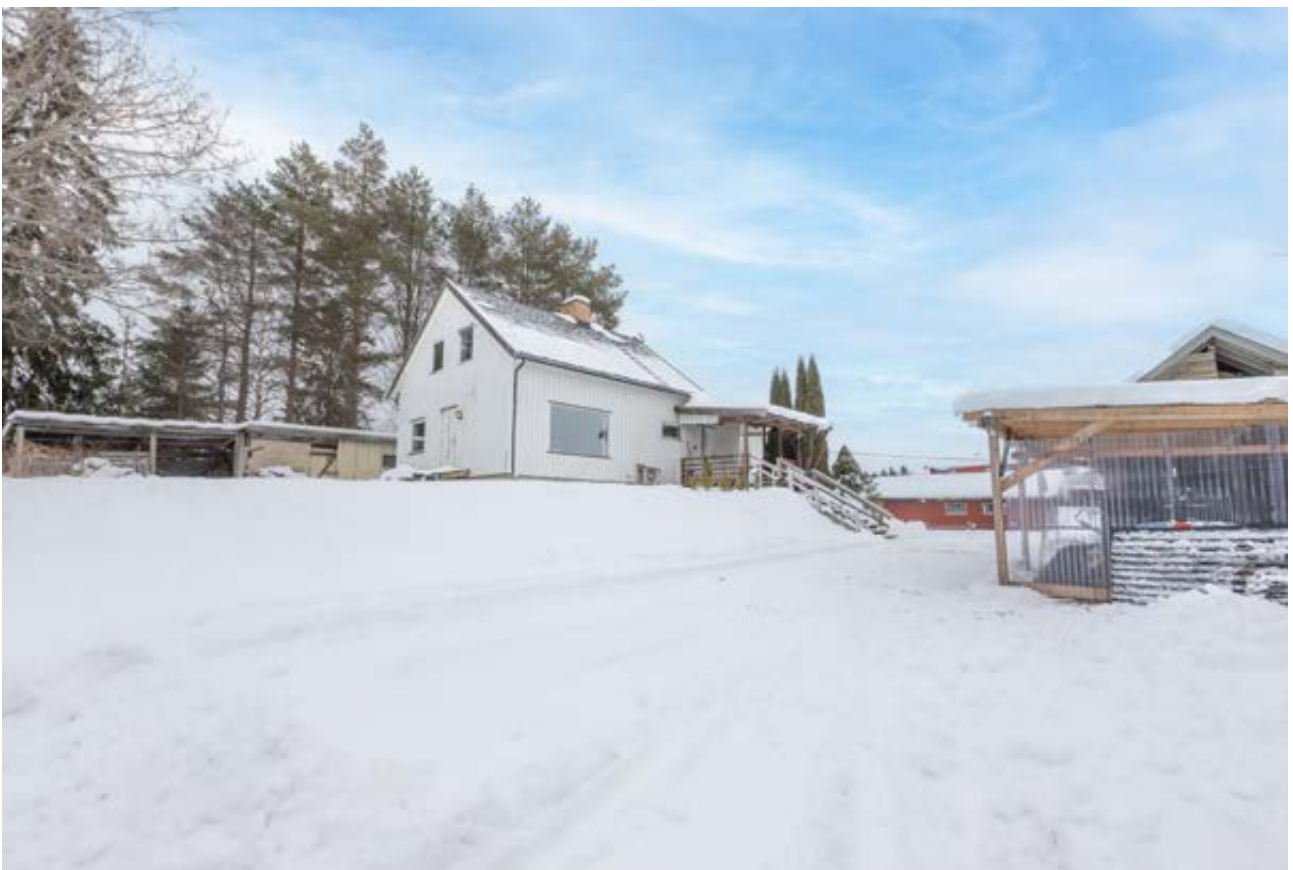
Enebolig fra 1966 med tilbygget del, ligger på en opparbeidet tomt med gruset adkomst.
