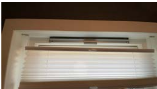
Spalteventil i vindu.
