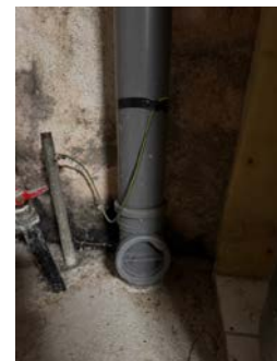
Soillrør med stakeluke i kjelleren.
