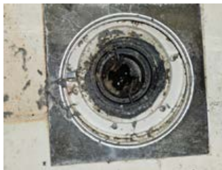
Plastsluk med mansjett og klemring
