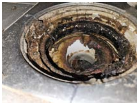
Plastsluk med mansjett og klemring
