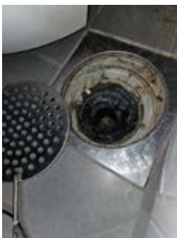
Plastsluk med mansjett og klemring
