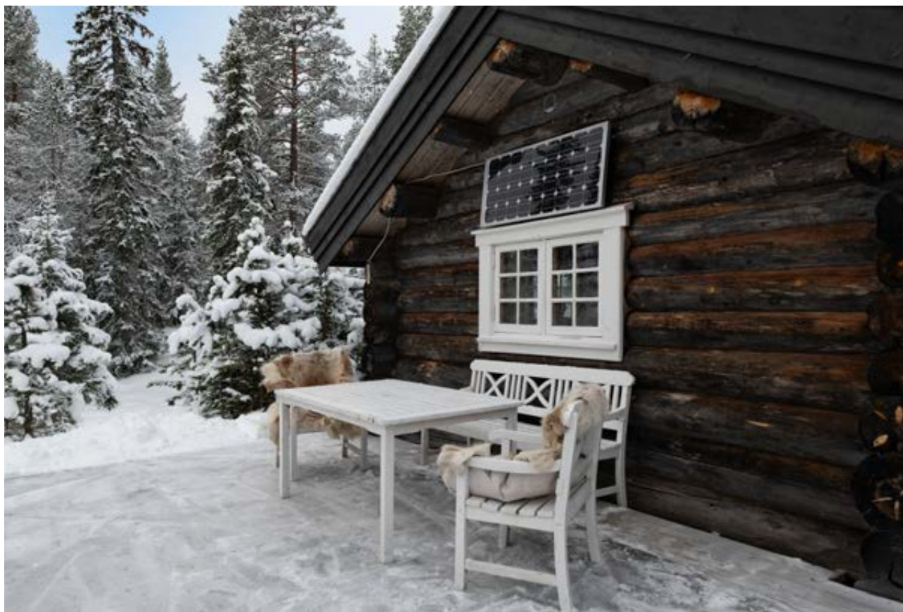
Solcelleanlegg er montert på hytta for bærekraftig energiforsyning.
