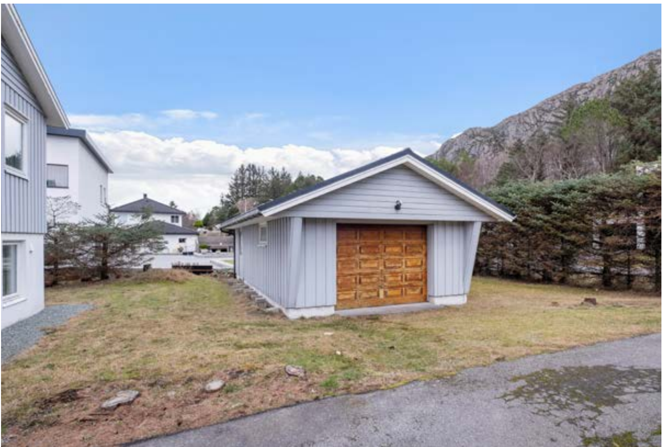
Garasjen har støpte fundamenter og en lakkert leddport, med enkel adkomst fra privat vei.
