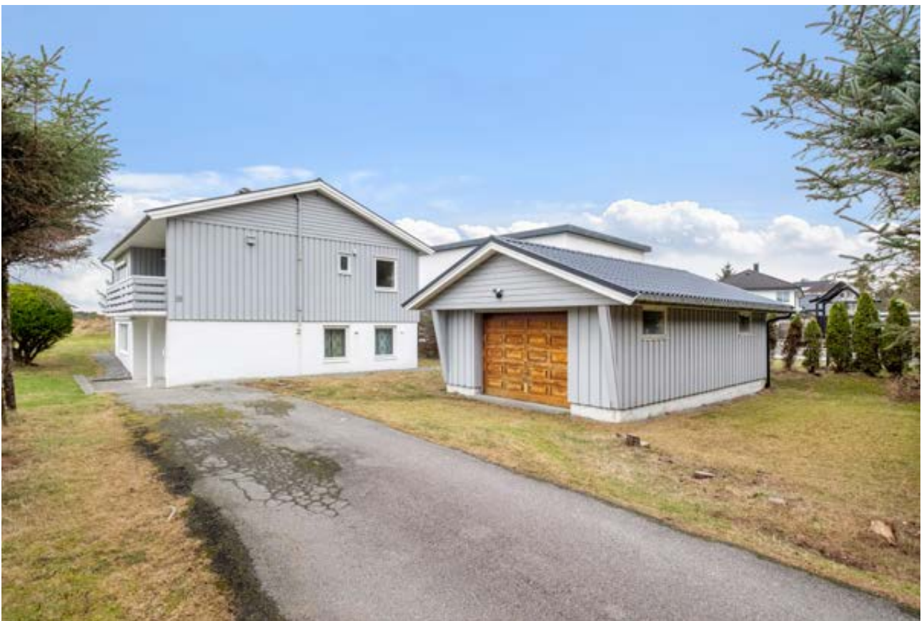
Garasjen har støpte fundamenter og liggende bordkledning.
