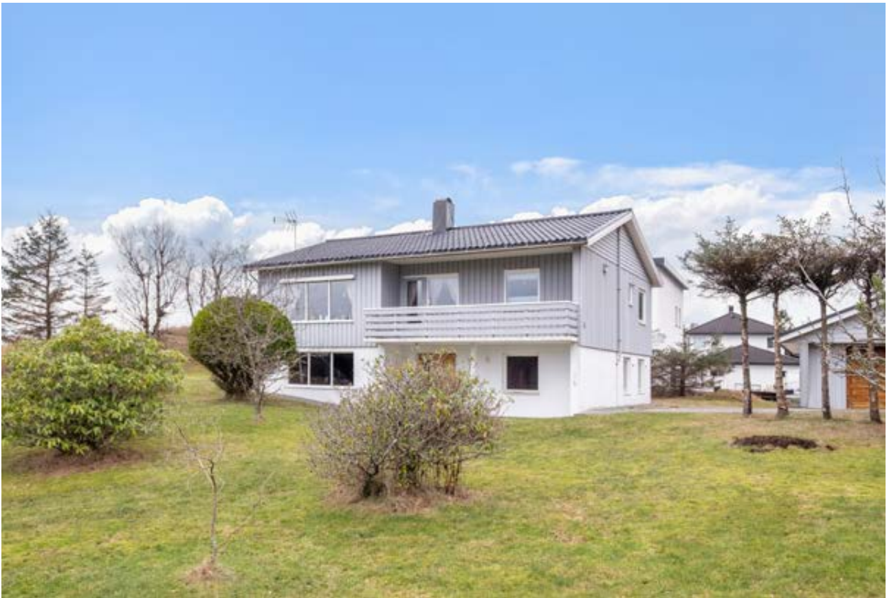
Boligen har en sørvendt balkong med betongunderlag og malt overflate.
