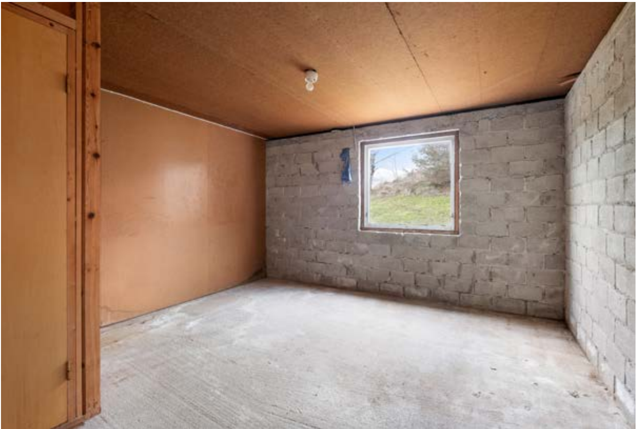
Ubehandlet murvegg og betonggulv gir et robust og enkelt vedlikeholdt rom.
