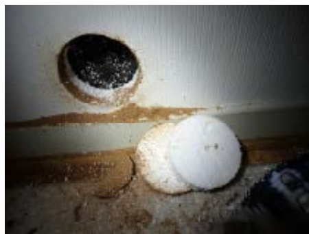
Isolert med isopor
