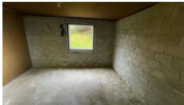
Ubehandlet betonggolv i bodareal
