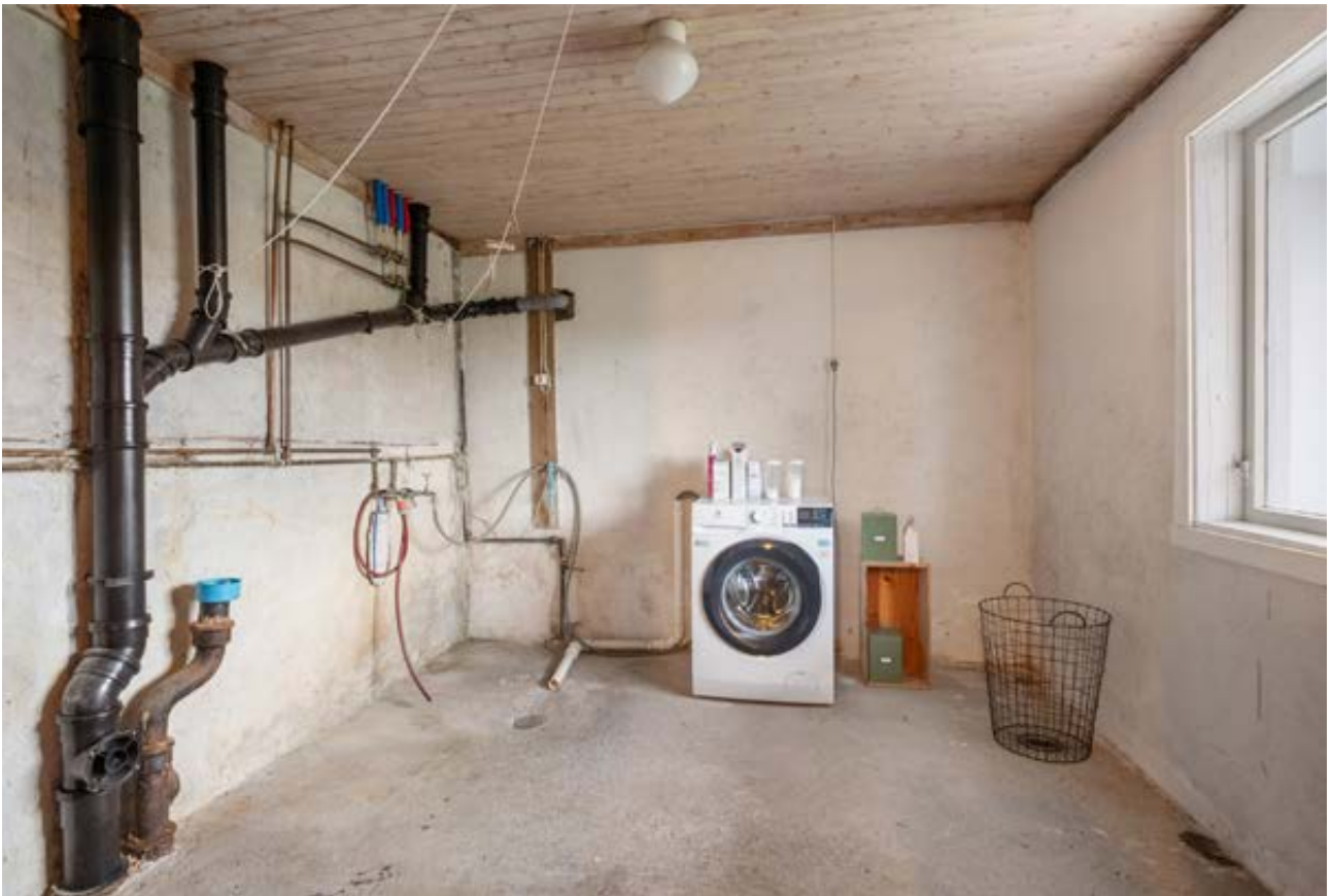
Vaskekjelleren har ubehandlet støpt gulv og vegger, med eldre støpejernsluk. Det er montert samlestock for vannrør og rør-i-rør system til badet.
