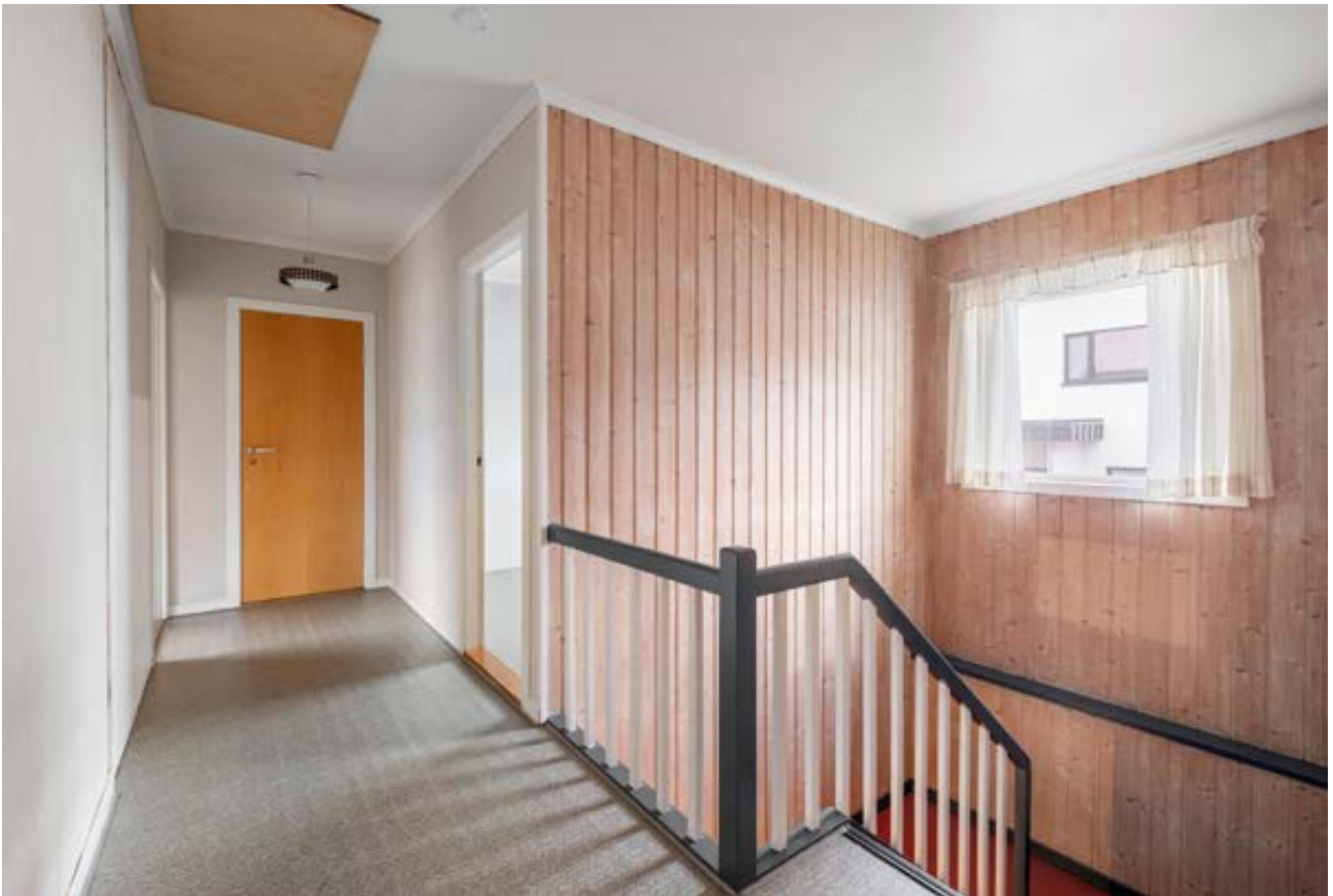
Tretrapp fra byggeår med tette stusstrinn og trerekkverk med stående spiler gir karakter til gangen.
