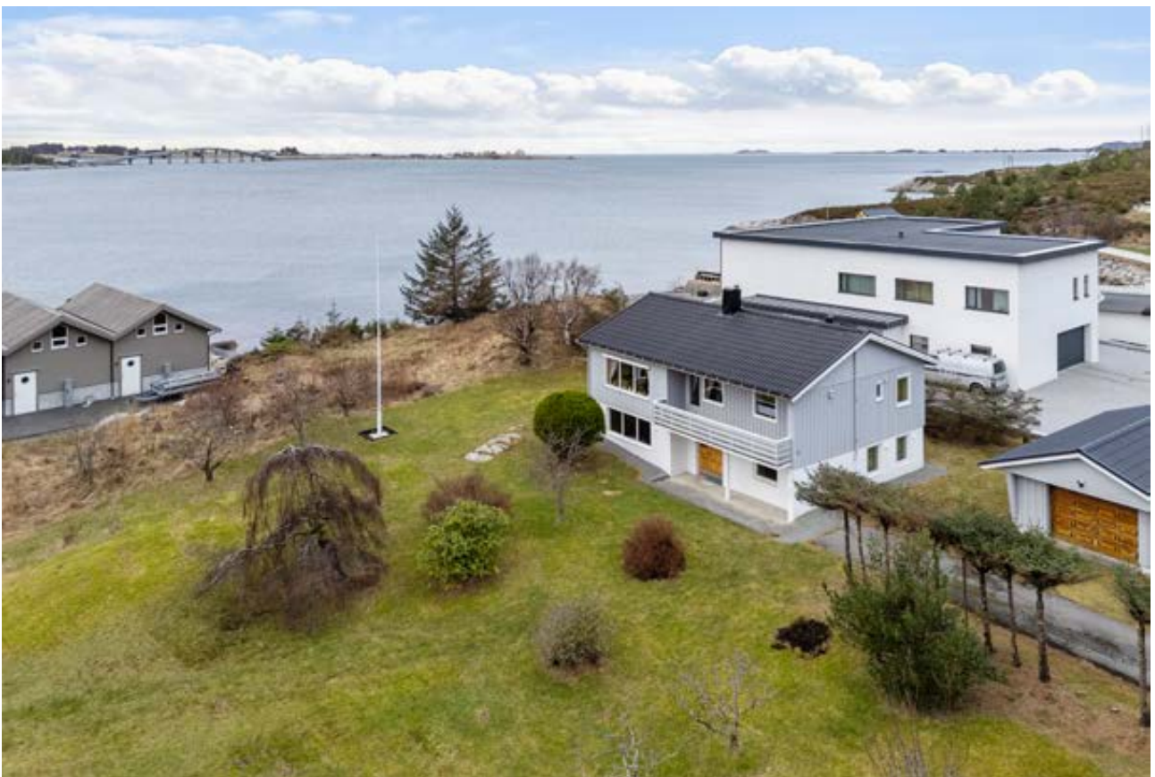
Tomten er opparbeidet med plenarealer og ligger på et lavere nivå enn boligen, med stående vann.
