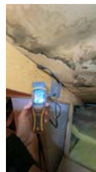
Fuktskjolder i undertak og isolasjon som ikke ligger korrekt.
