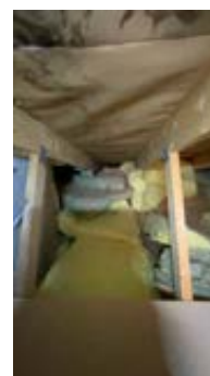
Fuktskjolder i undertak og isolasjon som ikke ligger korrekt.
