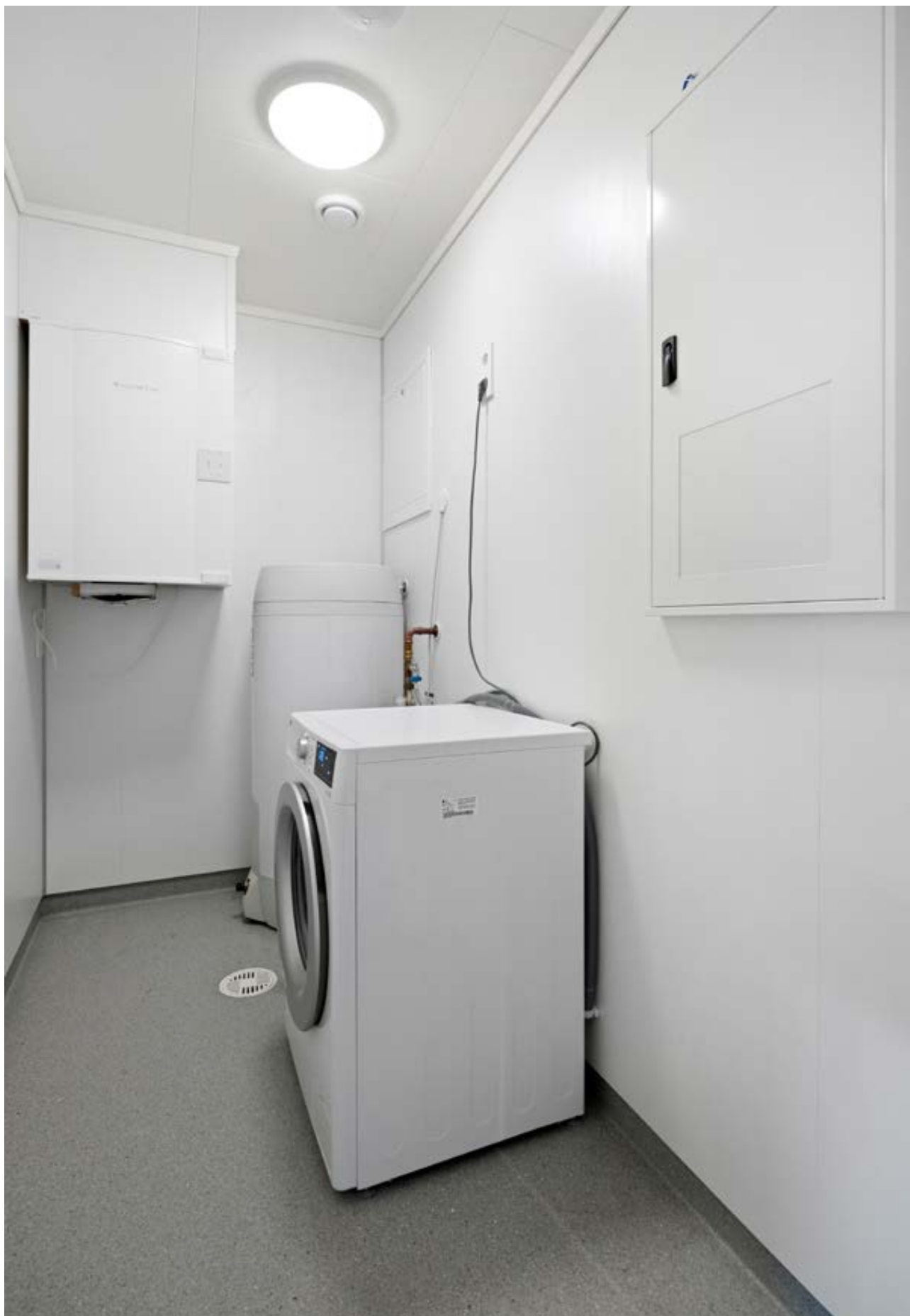
Vaskerommet har vinylbelegg på gulv og baderomsplater på veggene, med opplegg for vaskemaskin. Balansert ventilasjonsanlegg gir effektiv avtrekk i rommet.
