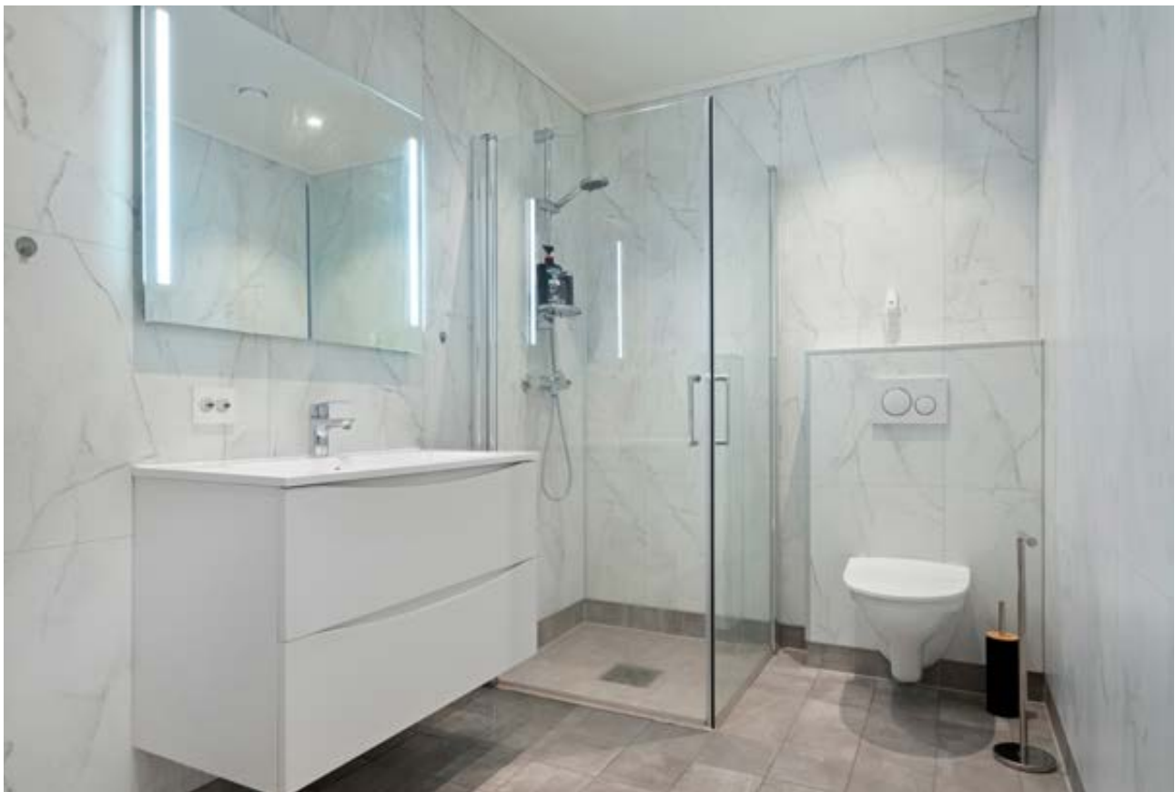
Flislagte gulv med gulvvarme og baderomsplater på vegger gir en komfortabel opplevelse (kilde: tilstandsrapport).
