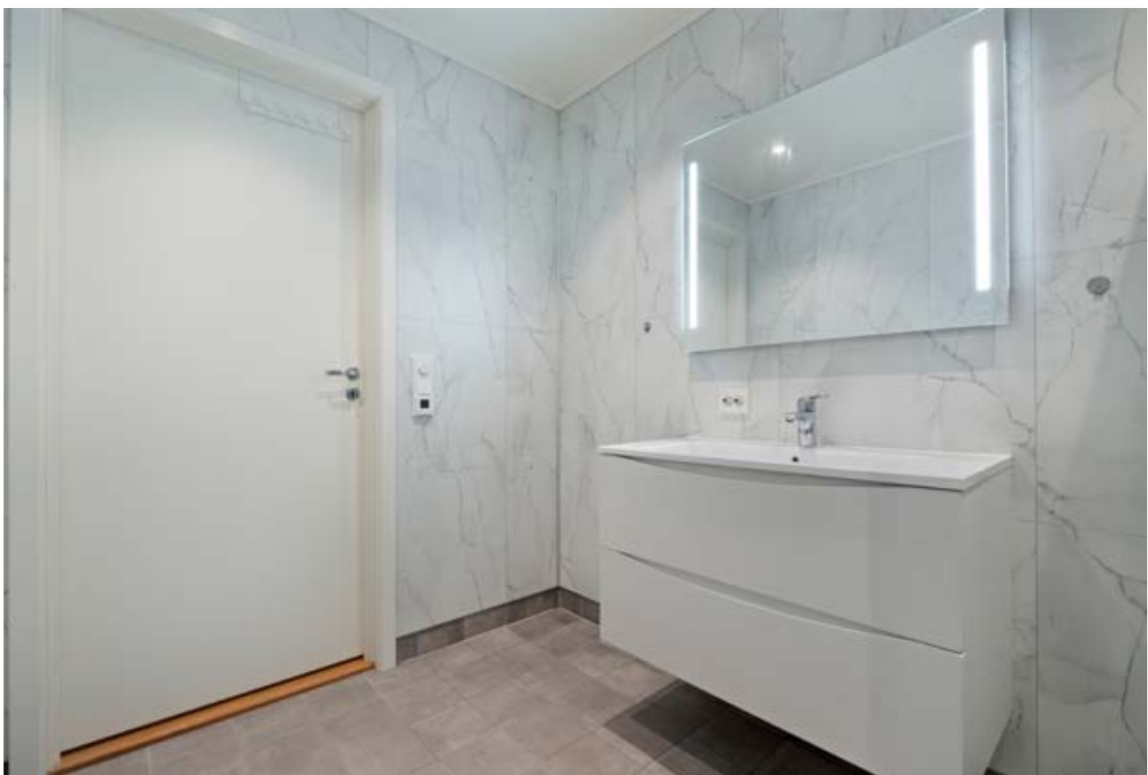
Balansert ventilasjonsanlegg sikrer godt innemiljø med avtrekk og tilluft via dørspalte (kilde: tilstandsrapport).
