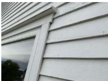
Overmalt råteskade
