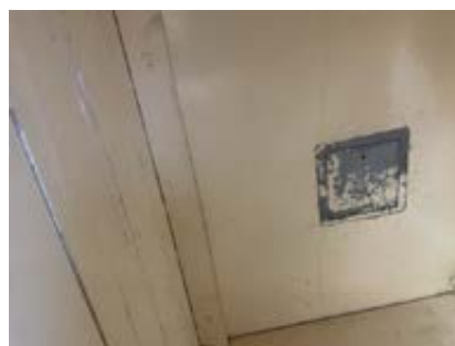
Veggventil i nedre del av skap
