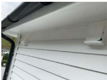
Korrodering metalleder
