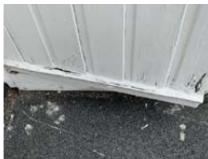
Råteskade altandør
