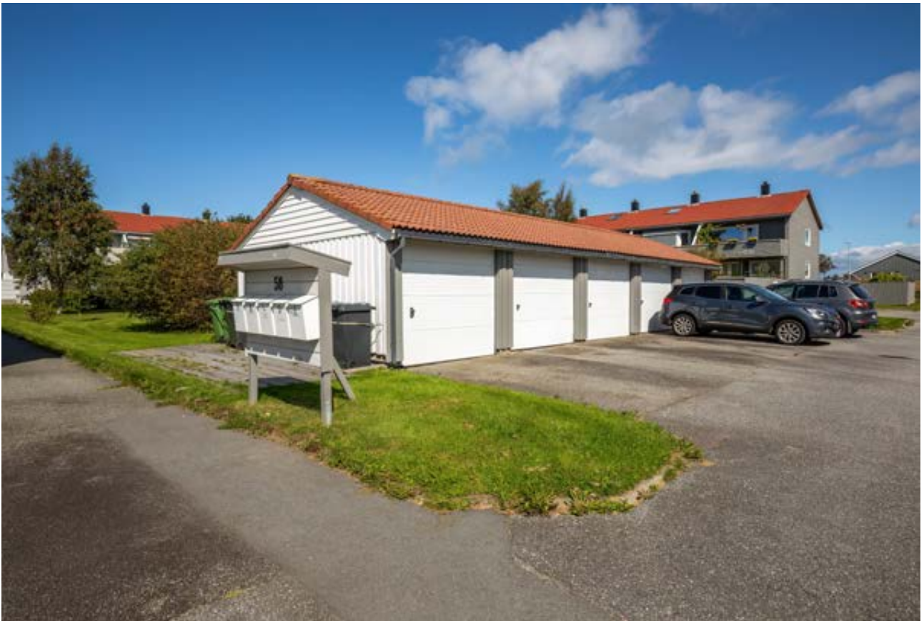
Garasjeanlegg med parkeringsplass gir praktisk biloppstilling.
